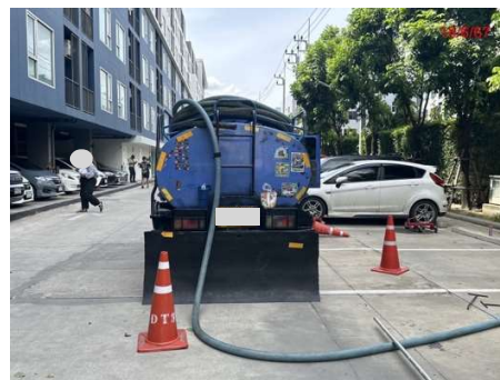
ภาพที่ 2.2-9 การทำความสะอาดบ่อดักไขมันและการสูบล้างปฏิภูม
