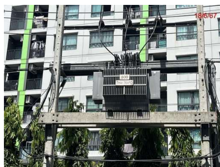
ภาพที่ 2.2-20 ห้องเครื่องไฟฟ้าและหม้อแปลงไฟฟ้าของโครงการ
