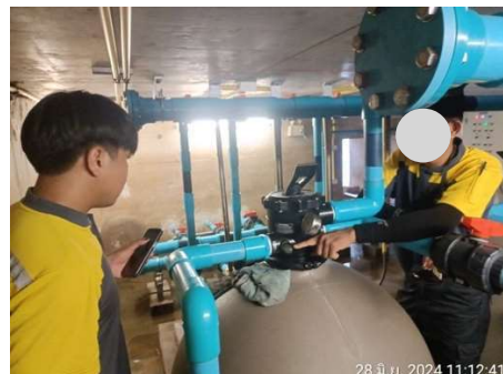
ภาพที่ 2.2-14 ระบบกรองของสระว่ายน้
