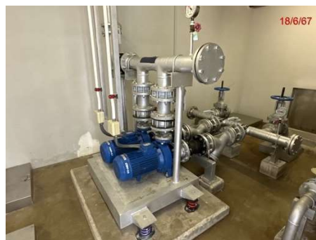
ภาพที่ 2.2-11 ระบบสูบน้ำประปา
