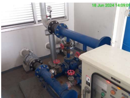
ภาพที่ 2.2-11 ระบบสูบน้ำประปา
